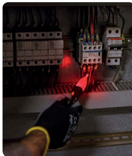
Detección de tensión CA sobre la funda de protección del cable, sin necesidad de tocar partes metálicas
